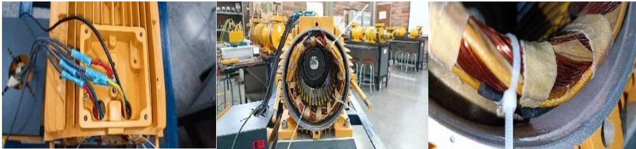
Figura 4. Instalación del sensor de temperatura en el devanado del estator.
