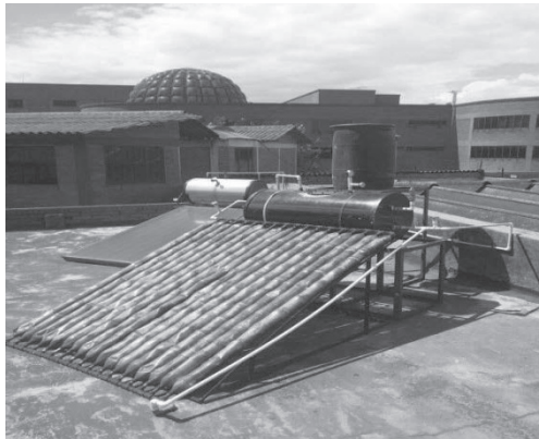
FIGURA 10. ENSAMBLE, TANQUE, CAPTADOR SOLAR, INSTRUMENTOS Y ACCESORIOS PARA SU CORRECTO FUNCIONAMIENTO.
